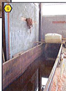
Bac de traitement du bois
